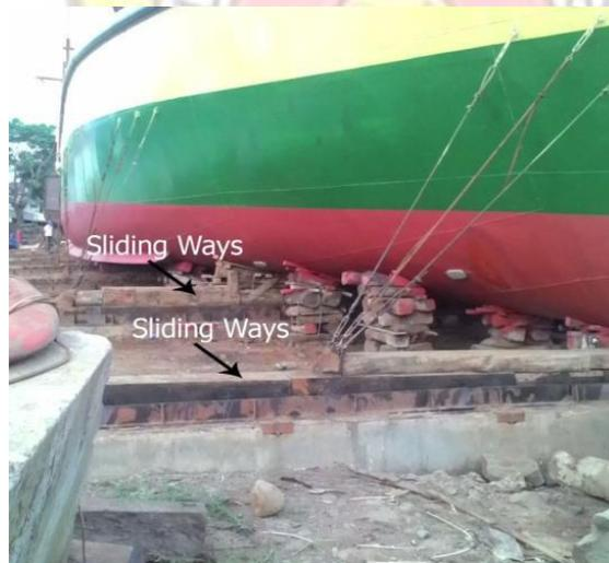
Gambar 2.1. Letak *Sliding ways* yang terbuat dari Balok Kayu
