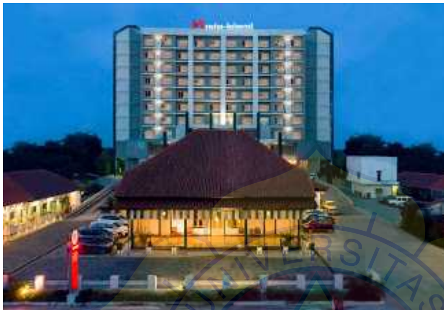
Rumah Marga Lay Tampak Depan Setelah Direnovasi Sumber : Mingky Lie, 2019
