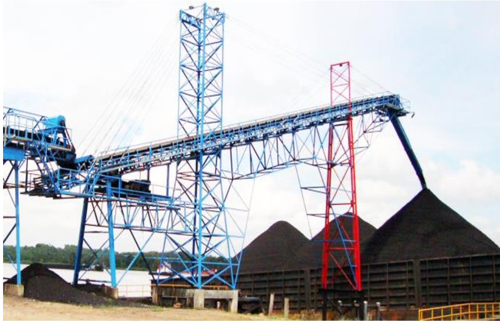
Gambar 2.7 Conveyor Muat Batubara di Pelabuhan (Jetty)
