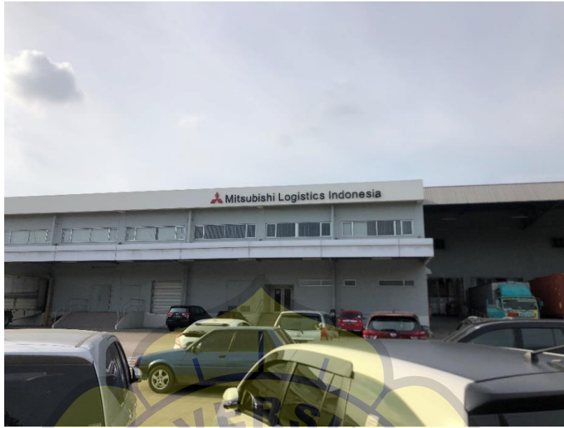
Proyek PT. Takenaka Indonesia warehouse PT. Mitsubishi Logistic Indonesia Cibitung Area, tempat penulis melaksanakan praktik kerja lapangan
