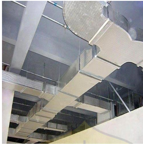
Gambar 19. Ducting segi empat
