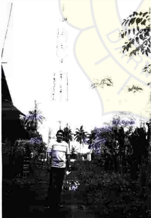
Gambar Lokasi BTS Batujaya
