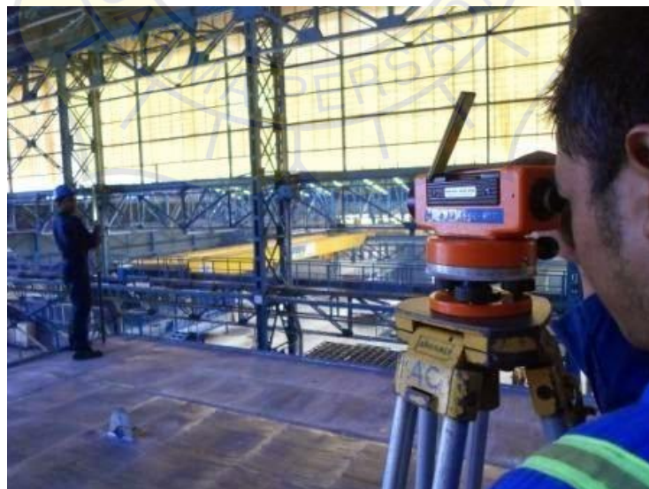
Gambar 2. 3 Pengukuran ketinggian Deck
