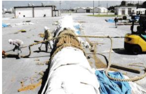
Gambar 2.14 Pemasangan Tali Rawai (手綱)
