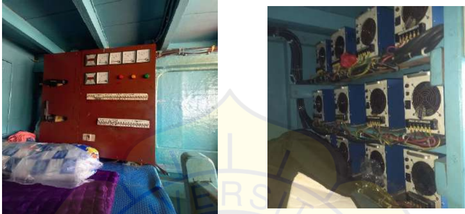
Sumber: Foto pribadi Gambar 2.20: Generator
