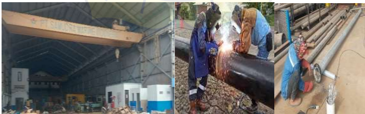
Gambar 20: Aktivitas Pekerjaan Pipa di Bengkel Pipa.
