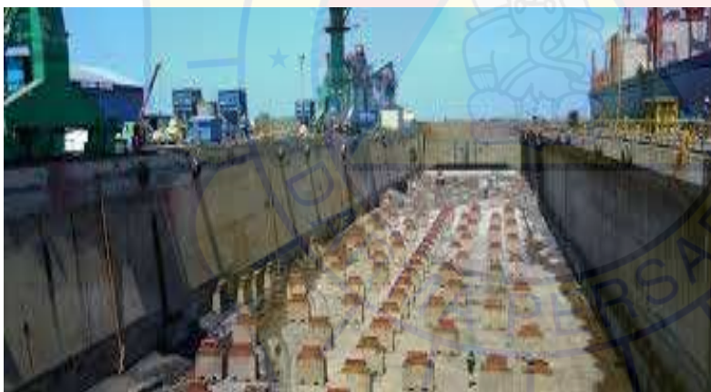
Gambar 19: Penyusunan Balok Ganjal Kapal
