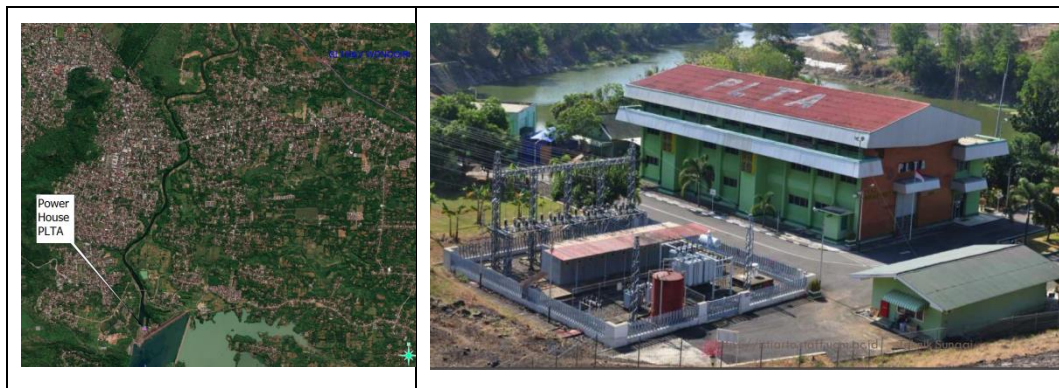
Gambar IV.6 Lokasi dan kondisi Swicthyard PLTA Wonogiri
